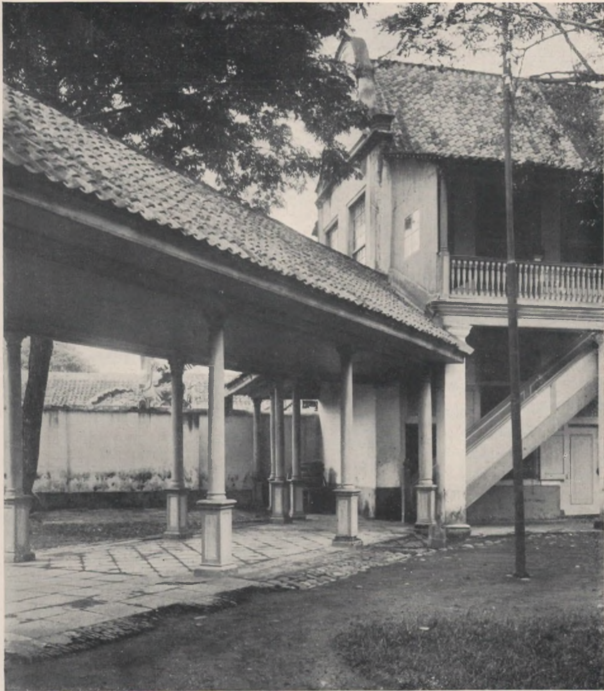
B 10a. Gezicht uit het Noorden op het achtererf van het huis B 10 met de door houten kolommen op vierkante voelstukken gedragen galerij van het hoofdgebouw naar de zuidelijke uit twee verdiepingen bestaande bijgebouwen. De trap naar de bovenverdieping komt overeen met die op de photo B 8a. Beneden zijn dispens, keuken enz., boven logeervertrekken, waarvan het voorste twee ramen naar Molenvliet heeft. De galerij der bovenverdieping komt overeen met die op A 21. Het plankenbeschol naar de straatzij is natuurlijk een later toevoegsel. De vierkante pilaren beneden zijn van baksteen. Met deze photo vergelijk men de omschrijving in eene acte van overschrijving anno 1770 van een huis aan den weg van Jacatra, waartoe behooren „twee groote agterhuijsen of zeijvleugels van twee verdiepingen, bestaande in een pakhuijs, dispens, combuijsen, slaavevertrekken”. Zoo heeft ook De Klerk's huis aan de andere zijde een dergelijk bijgebouw als het hier afgebeelde. Voor de slaven zal er eene aparte kombuis zijn geweest (vergelijk § 1221 noot).
