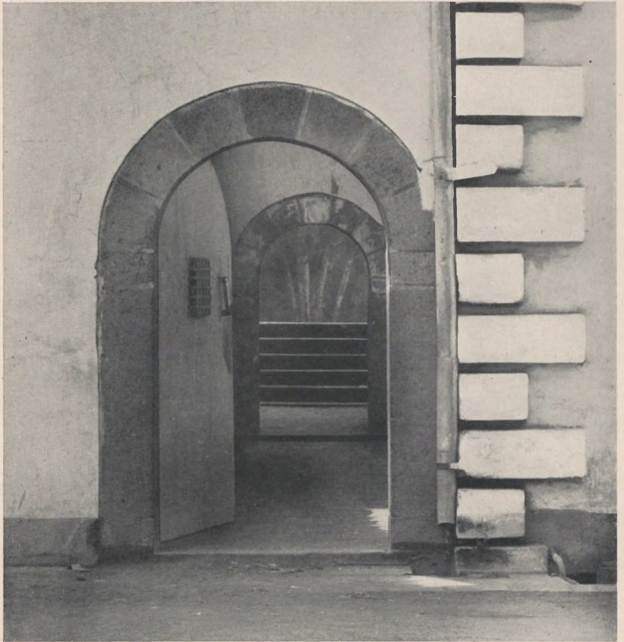
A 14. Poortje van Cormandelsteen aan de Binnenuwpoortstraat achter de stadsboeien (§ 521; 532). Zware houten deur met klopper en een met traliewerk voorzien spiegel, dat van achter met eene schuif gesloten kan worden. Hel poortje leidt naar een vrij diep van boven open portaal, bevoerd met Cormandelsteen, aan welks uiteinde een tweede poortje. De straaldeur of poort binnenkomend, heeft men links eene kamer, welke naar de oostzij eene deur met zeer ouderwelsch boventicht heeft, waarnaast een venster met luik. Dit zal de poortwachterskamer zijn. Verder zien op het portaal de achterkamers der stadsboeien uit; de achtergalerij daarvan behoort niet tot den oorspronkelijken bouw. Hel tweede steenen poortje bevallt vroeger twee deuren: eene lage naar de straatzij en eene hooge, die het poortje volkomen stoot, naar den kant der binnenplaats. Zette men deze hooge deur open, dan gaf de opening in het poortje boven de lage deur tenminste eenige luchtversching binnen het portaal. Vermoedelijk diende het portaal als recreatie-terrein voor de gegijzelden in de stadsboeien. Door het tweede poortje komt men in een tweede open portaal en daarachter op de trap achter het Stadhuis. Hel overeenkomstige poortje aan de oostzijde van het gebouw, achter de Compagniesboeien, is jammerlijk verbouwd. Echter wijst het bij A 13 vermelde spiegel in de deur aan den voorgevel op eene soortgelijke bestemming als ons poortje A 14, namelijk een directen toegang van de straat naar de „hokken“ aan de binnenplaats.
