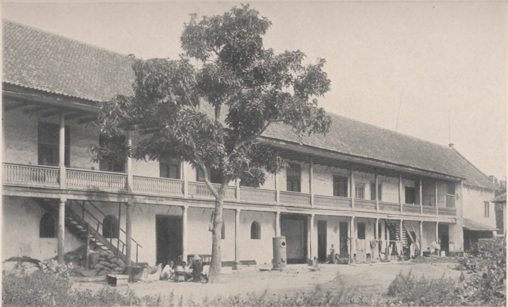
A 21. Gebouwen der Werf, gezien van de oostzijde of den kalikant. In het midden, rechts van den ouden stoomketel, de poort (§ 642); de houten kolommen bij dezen ingang worden beschermd door oude kanonloopen als schamppalen, gelijk men er bijv. te Utrecht zoo vele ziet. Men merke de schoone proporties dezer kolommen op en het fijne lijstwerk, dat den overgang vormt van de achtraaf der benedengalerij tot de balustrade daarboven. Omtrent deze balustrade vergelijkte men A 18, B 10a en die op Heydt's plaat der binnenplaats van het Gouvernement, K 6. Het middelgebouw der Werf, dat het grootste deel onzer plaat inneemt, sluit zich rechts aan bij een ouder gedeelte, dat, zooals de plaatsing der muurankers bewijst, het type aangeeft, hetwelk ook dit middendeel vroeger heeft gehad. Zonderling genoeg, komt dit type niet overeen met Vonk's afbeelding A 22, welke daarentegen weer wel overeenstemt met een op onze photo onzichtbaar gebouw aan de linkerhand, in het verlengde van ons middengebouw.
