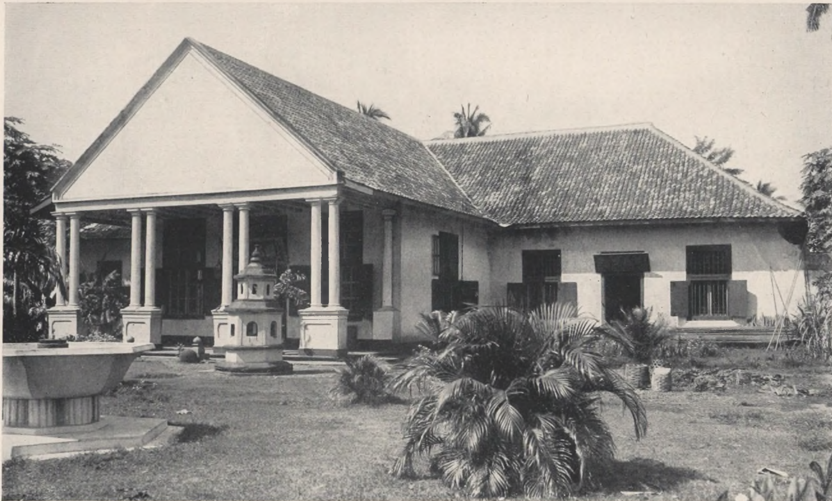
B 9. Achterzij (naar den kant van Goenoeng Sari) van het in 1736 door F. J. Coyett gebouwde landhuis, beschreven in § 1133 e.v. Dat dit de achterzij is, blijkt uit den stand der bijgebouwen. Het huis (thans de Chineesche tempel Sentiong) is zeer veranderd door het wegnemen der bovenverdieping van den middenbouw. Volgens mededeeling van een ooggetuige bezat die middenbouw een eigen dak, terwijl de vleugels afzonderlijke daken hadden, zoodat er drie daken naast elkaar stonden, waarvan het middelste het hoogste. De bekende Hindoebeelden bevinden zich in het achterdeel van den middenbouw. De in § 1133 vermelde consoles bevinden zich aan de zijkanen der achtergalerij, niet in die galerij zelve. In het Museum van het Batav. Genootschap bevindt zich de gevelsteen met het jaartal 1736 en het wapen van Coyett (dien wij zelf eertijds op Sentiong op zolder vonden) benevens de vazen van gebakken steen, die als dakversiering op den middenbouw stonden. Over de Chineesche begraafplaats alhier zie § 935.
