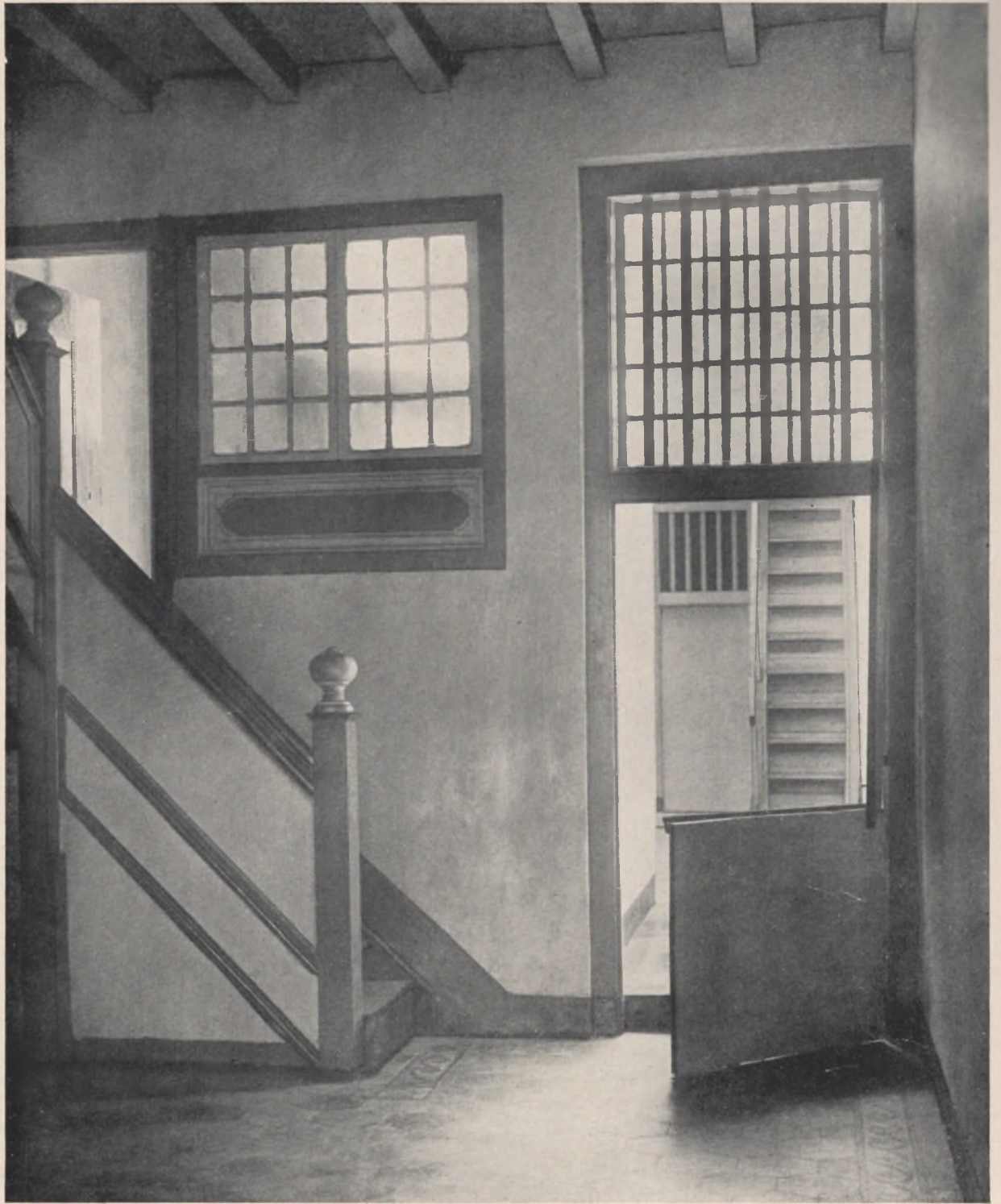
B 8a. Gezicht uit de zaal van het hujsje B 8 naar de binnenplaats. Onder de trap is eene deur naar het spinnelje. Op het bordesje neemt de trap de richting aan langs den zijwand naar een open vierhoek in den zolder, waaromheen op de bovenverdieping een hekje staat. Boven aan de trap hangt onder de leuning omgekeerd een knop van hetzelfde model als die op de beide hoofdbalusters. Men ziet verder de kelderkamer met een raam aan den zaalkant en een naar de binnenplaats; voorts aan de achterzij der binnenplaats de trap naar de slavenkamer en de deur van het gemakhujsje.
