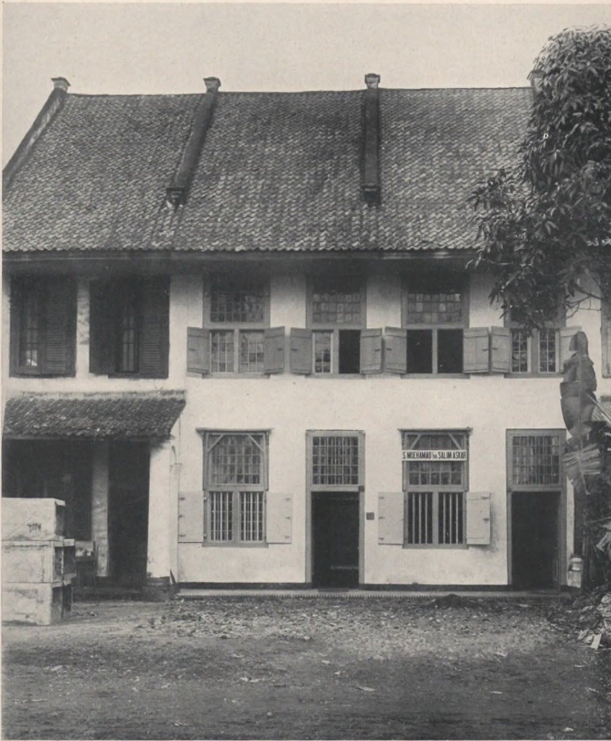
B 8. Groep van twee huisjes aan de oostzij der Roëa Malaka of Jonkersgracht even bezuiden de Utrechtsche straat, links No. 10, rechts No. 8. De plattegrond van het zuidelijkste (No. 8) is opgenomen in onzen tekst; zie § 1089 e.v., alwaar de heele inrichting beschreven staat. Het andere huisje heeft eene andere indeeling der bijgebouwen. Het houten raam, dat beide huisjes in de benedenverdieping hebben om een zeilje over te spannen (zie op plaat K 5) is modern. In 1921 werden deze beide huisjes door den 'Gezondheidsdienst als „pestgevaarlijk“ gestolen, helgeen eene aanwijzing is van hun naderend uiteinde.
