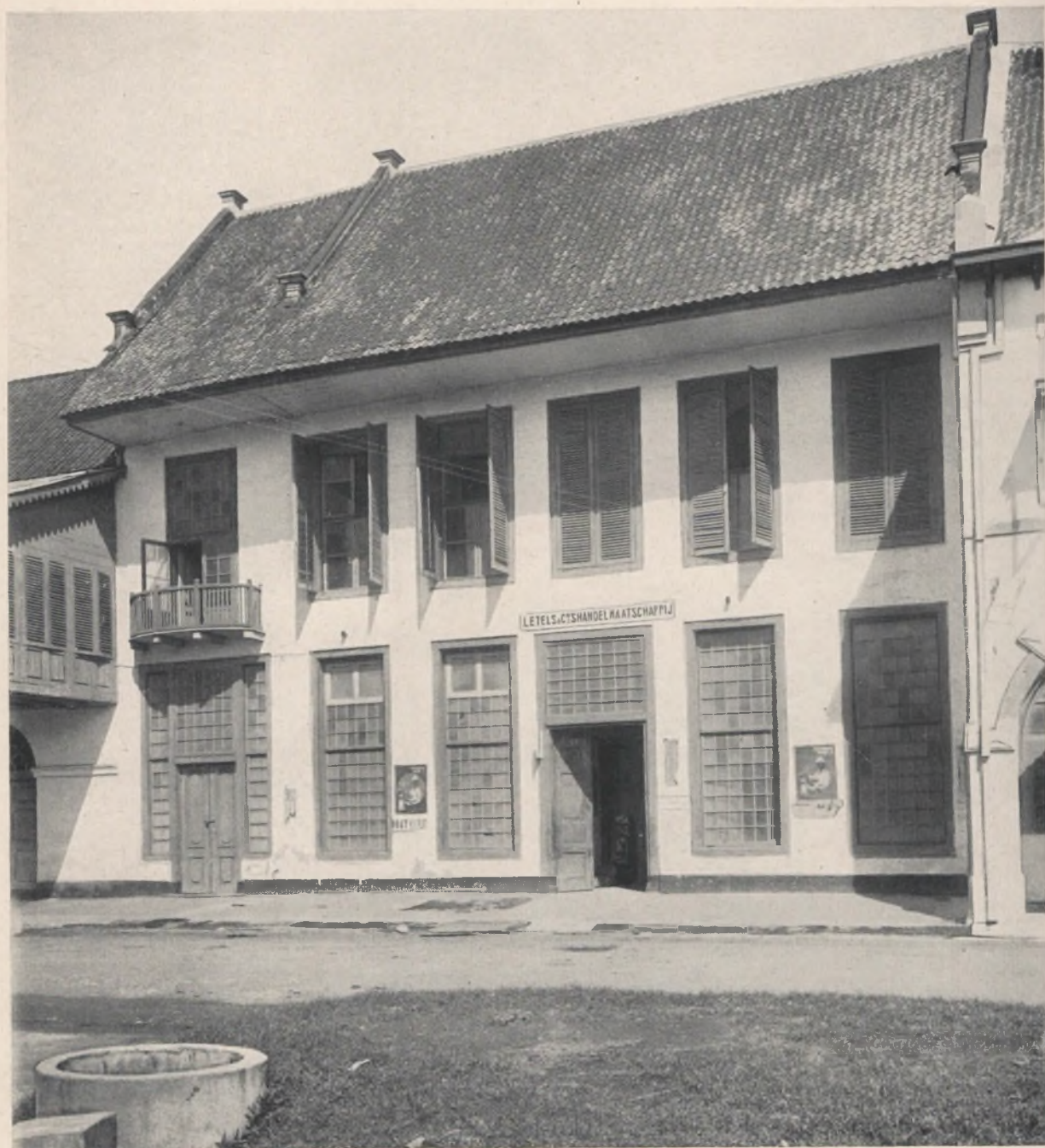
B 7. Twee huizen onder één dak aan het zuidende van Kalibesar West, samen uitmakend het kantoor met opslagplaats van Tels en Co., sederl aangekocht door eene Engelsche bank en gerestaureerd. Het huisje links had oudtijds eene aparte binnenplaats en apart achterhuis. Bij het afbikken van den voorgevel kwam hier ook heel ander en veel slechter metselwerk voor den dag dan bij het groote huis. Opmerkelijk is, dat de bovenhelft der smalle nevenramen naast de deur naar beneden kan worden geschoven (§ 1086). Het kan zijn dat dit huisje in October 1777 werd bewoond door F. Von Wurmb, die volgens zijne brieven aan Kalibesar West woonde, dicht bij de Diestpoort. Beneden woonde de Eerste Klerk ter Algemeene Secretarie, Ph. De Elwijk, een Pool; deze had aldaar slechts ééne kamer voor zich (denkelijk de voorkamer of het voorhuis), terwijl de rest (dus de zaal, plaats en bijgebouwen) in gemeenschappelijk gebruik was. Von Wurmb woonde boven. De restauratie van deze twee huizen in 1920 en 1921 heeft de oude samenstelling geheel veranderd. Zoo is het binnenplaatsje van het kleine huis samengetrokken met het zuidelijke binnenplaatsje van het groote, terwijl de trap uit het groote huis naar het kleine is overgebracht. Niettemin blijft het een schilderachtig interieur. Over de zonderlinge kluis alhier zie § 1186, en over de donkere kamer § 1110 noot.
