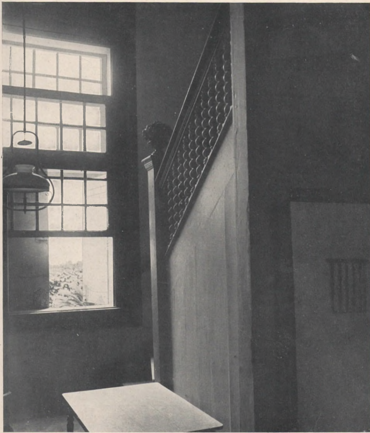
B 11a. Trap in de middelste der drie zuidelijke zijkamers van het huis B II. Daaronder (rechts) de deur van het spinnetje. De hoofdbaluster draagt een bloempot met bloemen van houtsnijwerk. De balusters zijn „geslingerde lralies” (§ II66). Op de bovenverdieping eindigt deze trap in een eenvoudig hekje op een portaal, dat over de heele breedte van het huis loopt en waarop uitkomen drie voor- en drie achterkamers. Zonderling is de slechte verlichting der bovenkamers. De voorkamers moeten al haar licht uit de voorgalerij hebben; van de achterkamers hadden de twee buitenste geene buitenramen, zoodat al het licht uit het portaal kwam. Blijkbaar voelde men zich zoo ver van de stad 's nachts daarboven lang niet veilig. Men zie op de photo, dat de benedenkamers halve buitenluiken hebben met kunstig shuitwerk; de vaste bovenhelft van het schuifraam heeft geen luik.
