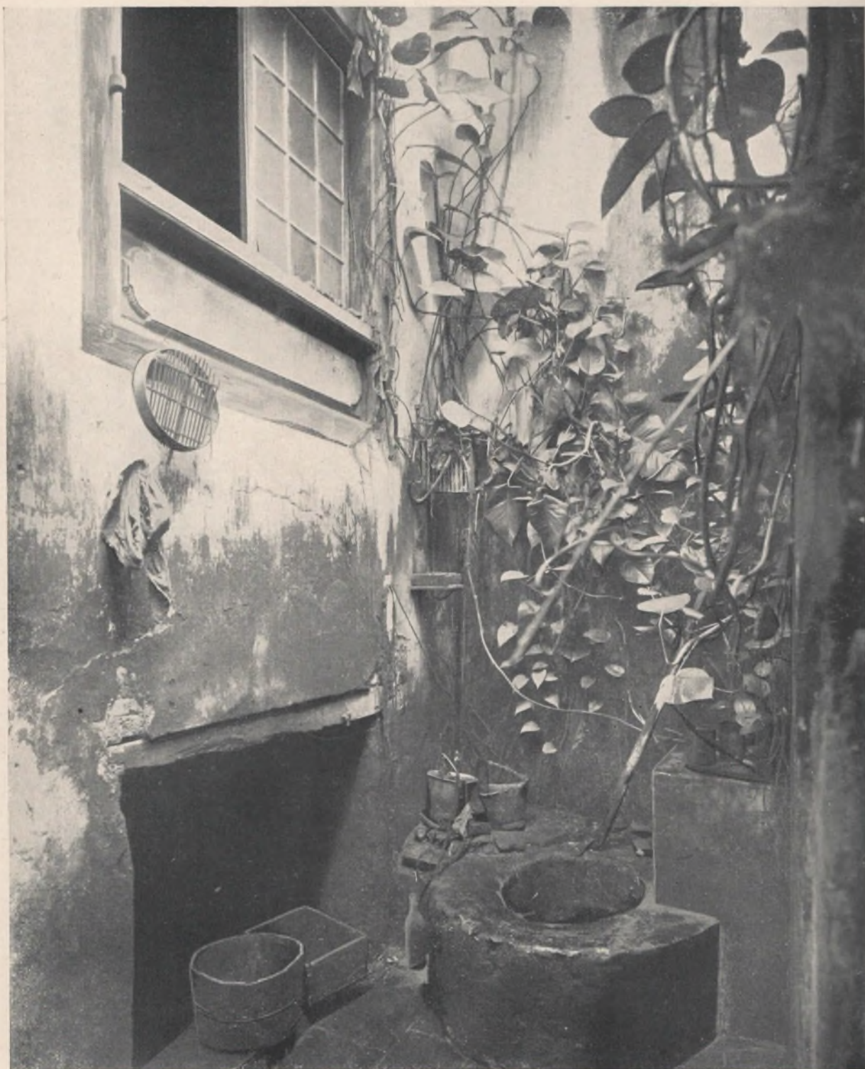
B 22. Binnenplaats van een ander huisje aan de Roëa Malaka. Deze plaats bepaalt zich tot een put, besloten tusschen de muren van hoofdgebouw en bijgebouwen. Links de kelder (het raam daarvoor ontbreekt) en daarboven de kelderkamer. Langs de wanden woekerplanten. De put ontvangt het zonlicht alleen wanneer de zon er recht boven staat. Bij regen stroomt het water der daken over het plaatsje. Niettemin zal die kelderkamer wel gebruikt zijn voor slaappleats. Dit plaatje is wel de schoonste toelichting bij een opstel over de ongezondheid van Oud-Batavia.
