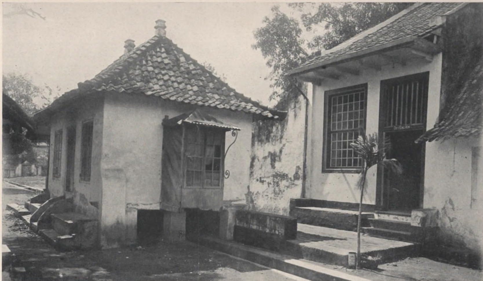
B 14. Oud-Hollandsch koepeltje (thans moskeetje) en huis in Gang Blandongan (over welke buurt zie bij B 3), vermeld in § 1137. De waterleiding komt naar de linkerzij der photo uit de Krokot. Naar dien kant heeft het huisje een voorgalerijtje met houten pilaren. Boven de deur staat in het Maleisch in Arabische karakters: „Dit is de stichting ten algemeenen nutte van Kapitein Abdoel Latif“. De „stichting“ heeft dan bestaan in de toevoeging van de mihrab of nis, die het fraaie gebouwtje zoo ontsiert; zij zal geprovoceerd wezen door het stroomend water, benoodigd voor de ritueele wasschingen. Mohammad Abdoel Latif was Kapitein der Baliërs van kampong Angkee (wat bewesten Gang Blandongan) van 1772 tot 1800. Het niet minder aardige woonhuis, dat hetzelfde type van deur en venster vertoont als B 13, heeft een drempel van Cormandelsteen en daaronder eene rij witte tegeltjes. De draagbalkjes met sleutelstukken aan den uitsteker zijn zuiver Hollandsch (in tegenstelling tot die op B 3). De bijgebouwen zijn niet achter doch naar rechts in het verlengde van het voorhuis. Het is jammer, dat wij niet hebben kunnen uitmaken of een Hollander hier ooit heeft gewoond. De schuld daarvan ligt aan den slechten staat van het kadastraal archief.
