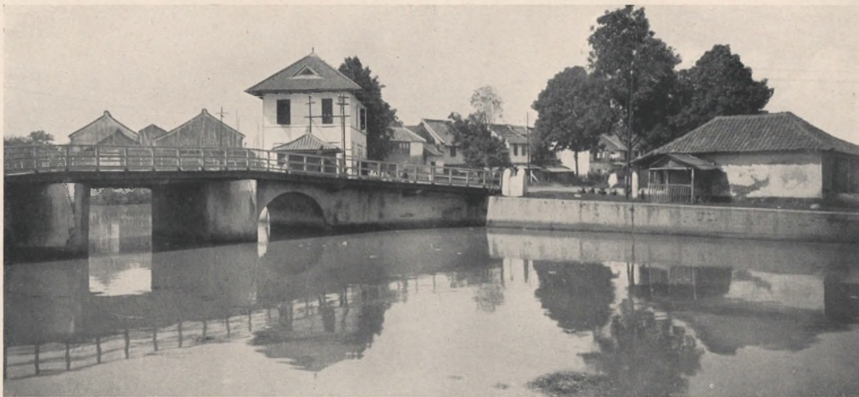
A 6. Gezicht van uit Kalibesar Oost op de Javabankbrug (oudlijds de Hospitaalsbrug § 497). Men vergelijke deze photo met Rach's van uit hetzelfde standpunt geteekend stadsgezicht (No. K 18). Sedert de photo werd genomen, is het oude wachthuis aan den waterkant afgebroken. Men noteere het dak in neo-Batavia stijl van het wille gebouw achter de brug met uitsteker en blikken schoorsteenlje (§ 1076).
