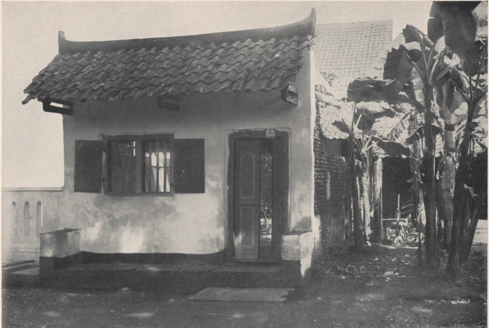
B 19. Huisje in Gang Mesigit bezuiden de Ammanusgracht met loozen muur (waarin eene gepaneelde deur en venster) en een luinlje als voorerf, vermeld in § 1119 noot. De muur draagt eene soort uitsleker; zijne opwaarts krullende topeinden wijzen op een Chinees als bouwmeester, zie B 3.
