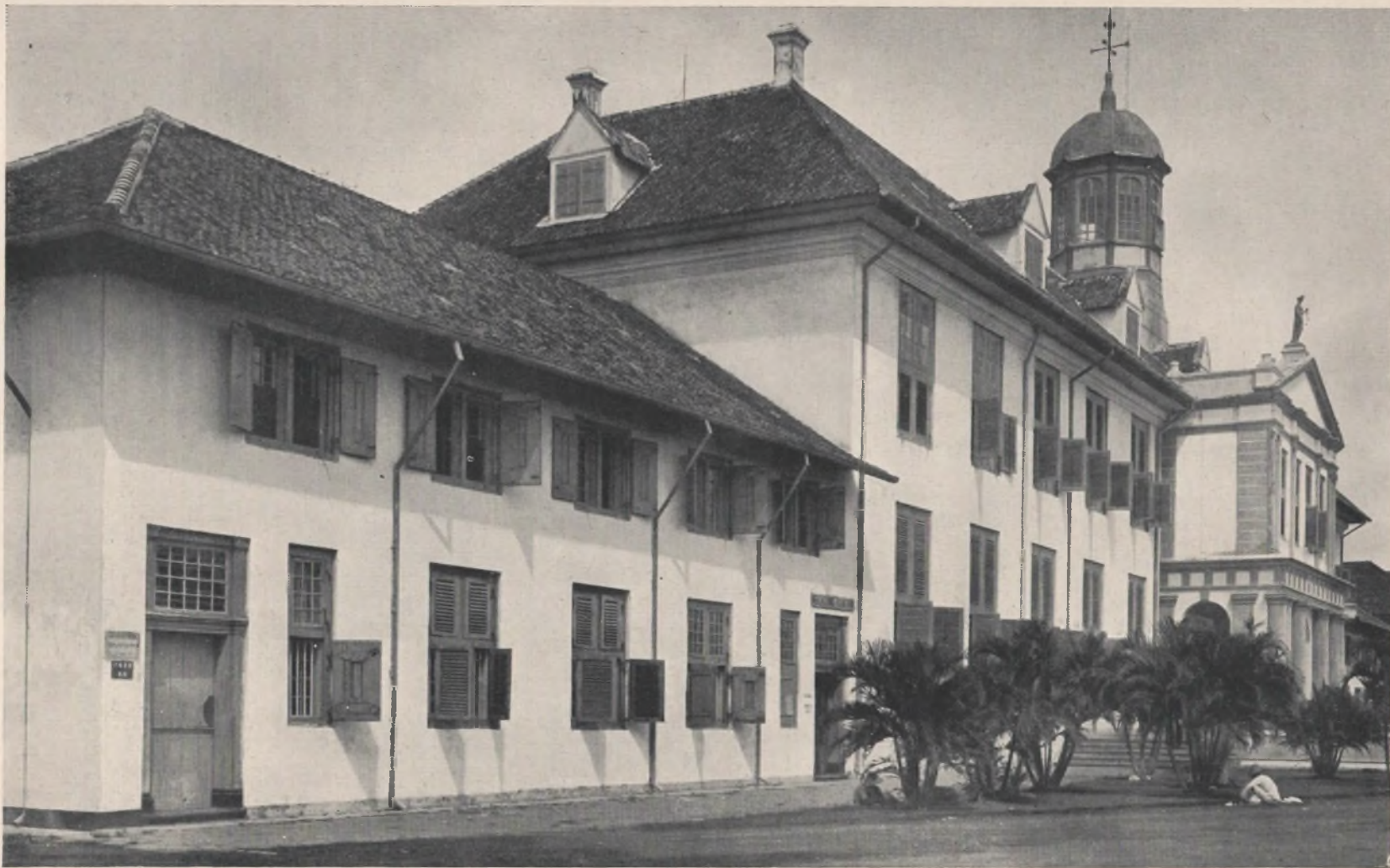
A 13. Gezicht van terzijde op de voorgevel van het Stadhuis. Links de Compagniesboeien (§ 527). Over de vensters daarvan zie § 1085. De bovenverdieping heeft kleine vensters, die naar binnen openslaan. De deur rechts van de cipierswoning, waarboven: Belastingkantoor, had vroeger een spiegel. Zij leidt naar een ruim portaal, dat oorspronkelijk geene verbinding met het cipiershuis had; in dat portaal bevindt zich de trap naar de bovenverdieping. De burgerboeien aan den anderen kant van het gebouw vertoonen aan de bovenverdieping slechts drie venstertjes, en gelijkvloers (van het hoofdgebouw af gerekend): eene deur, een smal venster daarnaast en twee grootere. Beneden deze twee laatste vensters bevinden zich gelijk met den grond de twee lage en met luiken gesloten vensters van het donker gat (§ 527; 528).
