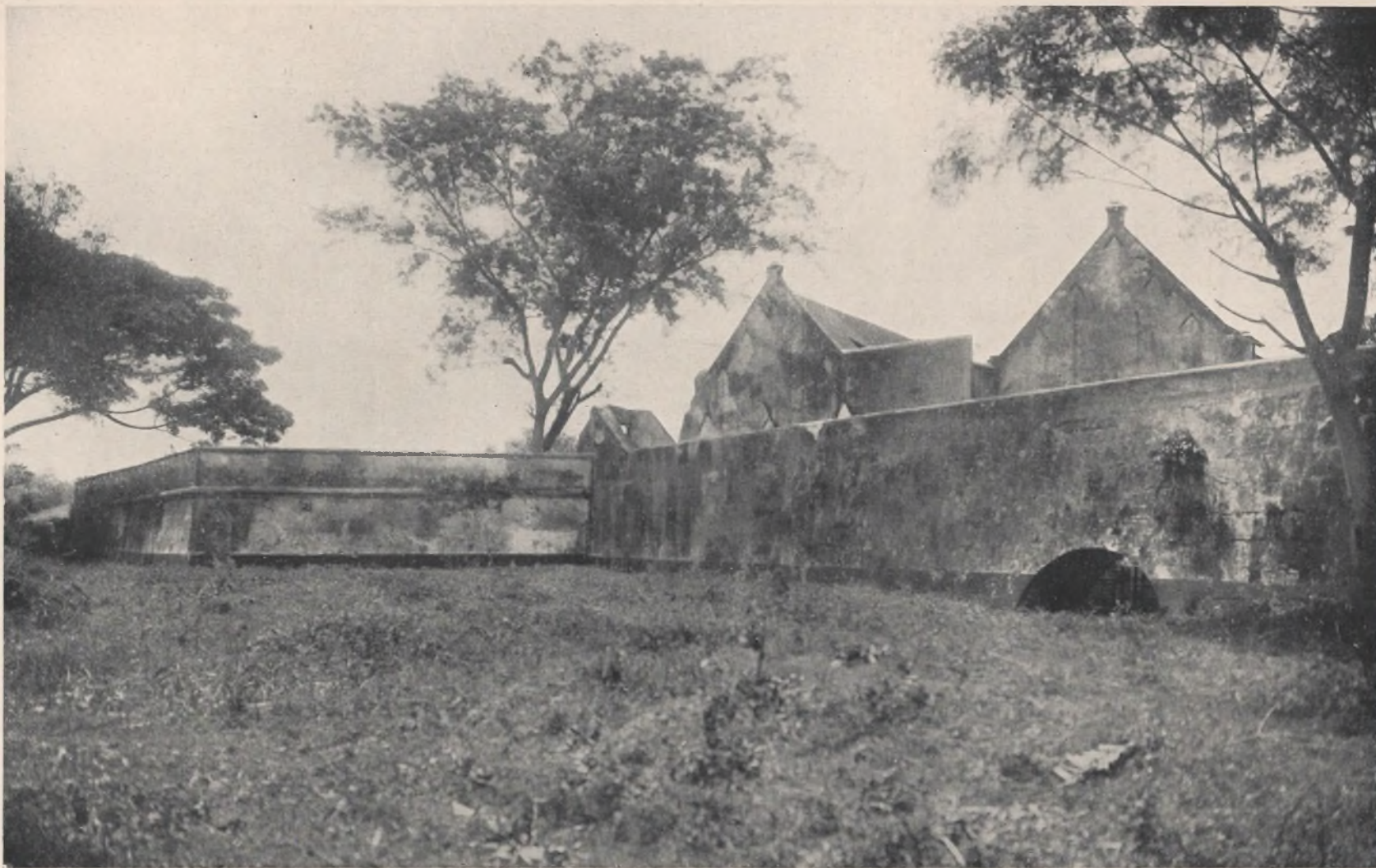
A I. Gezicht uit het Noorden op den stadswal tusschen Groningen (rechts; bestaat niet meer) en Zeeburg. De wal is ongeveer 4.25 M. hoog. Op den hoek de ruïne van een poortje. Achter den wal de noordzijde der Westzijdsche pakhuizen (§ 697). Over den duiker in den wal zie § 485 en over den wal zelf § 413. Zeeburg had in den lateren Compagniestijd denkelijk geene tinnen of borsluring, evenmin als Culemborg die heeft op eene plaat van Rach. Men bereikt dit terrein door benoorden den Uitkijk den waterkant te volgen. In den regel echter is dit pad versperd en het terrein vóór den stadswal dicht begroeid.
