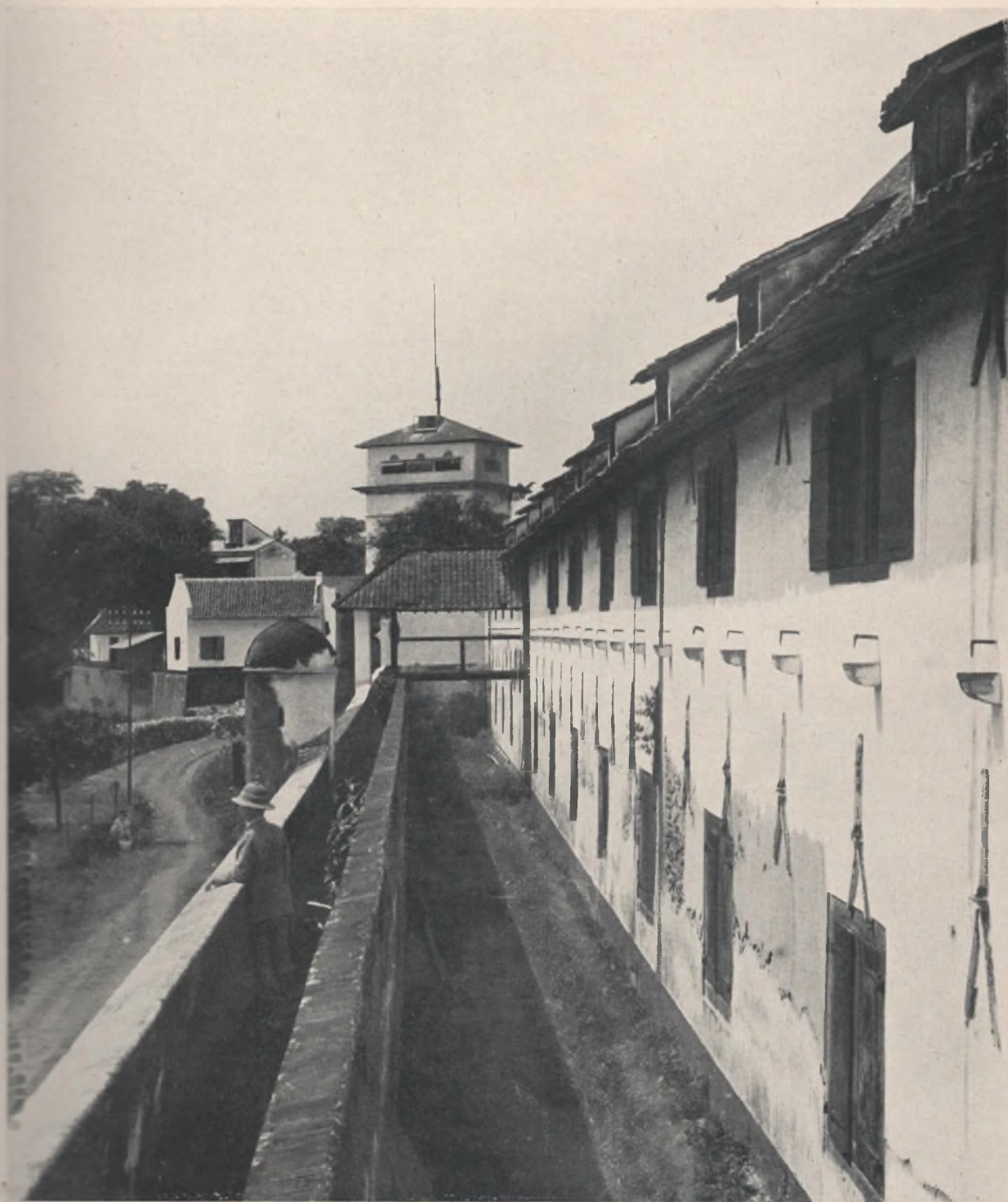
A 3. Gezicht van uit het Noorden op Culemborg en den Uilkijk. Rechts de Westzijdsche pakhuizen, in het midden de stadswal met walgang (§ 414) en een peperbusvormig schilderhuis. In den pakhuismuur de uitstekende koppes der zolderbalken, waarover vroeger balken lagen (vastgehouden door de ijzeren krammen), welke de galerij drægen (§ 414) voor de patrolle. De brug over de open ruimte tusschen den wal en het pakhuis is, evenals de trap, die van den beganen grond naar deze brug leidt, een later toevoegsel. Het gezicht is genomen van uit de tweede dergelijke brug.
