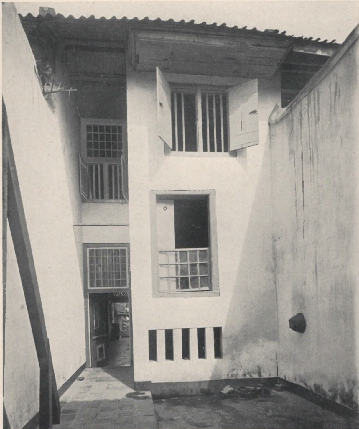
B 8c. Gezicht van uit de achterzij der binnenplaats van het huisje B 8 naar de voordeur. Links de trapleuning, rechts de pul. In den uitbouw der hoofdwooning zijn beneden de luchtgaten van den kelder; daarboven het venster der kelderkamer; daarboven het venster eener boven- of slaapkamer van hetzelfde oppervlak als de kelderkamer. Links van den uitbouw het open portaal naar de achterdeur der zaal; door deze deur heen ziet men de zaal, de binnendeur, en het voorhuis benevens de openslaande voordeur. Boven de achterdeur der zaal ziet men een venster der bovenzaal, welke hetzelfde oppervlak heeft als de zaal en waarin de trap uitkomt. Aan de straatzij bevinden zich twee bovenvoorkamers, overeenkomend met het voorhuis en de zijkamer der benedenverdieping.
