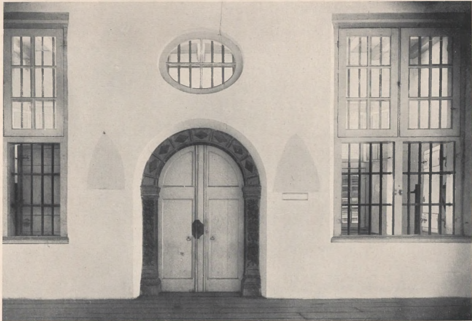
A 16. Gezicht vanuit het portaal op de bovenverdieping van het Stadhuis naar den kant van den voorgevel (d.i. naar de achterzij van het kamertje, dat de bovenverdieping van den middenbouw uitmaakt, § 520). Het poortje van Cormandelsteen heeft eenig primitief ornament. De koekoek daarboven doet zien, hoe ondiep het kamertje is. Hier zaten Schepenen bij eene executie. Zoowel de deur als de luiken van de benedenhelft der vensters zijn buitengewoon solied evenals ook het traliwerk. Schepenen zaten daar letterlijk gebarrikadeerd. Wat de dichtgepleisterde driehoekige openingen aan weerskanten der deur zijn, is ons niet bekend. Wellicht stond daar vroeger eene lamp of kandelaar. Het is echter ook wel mogelijk, dat het de eerste Bataviasche brievenbussen zijn geweest (§ 1588).
