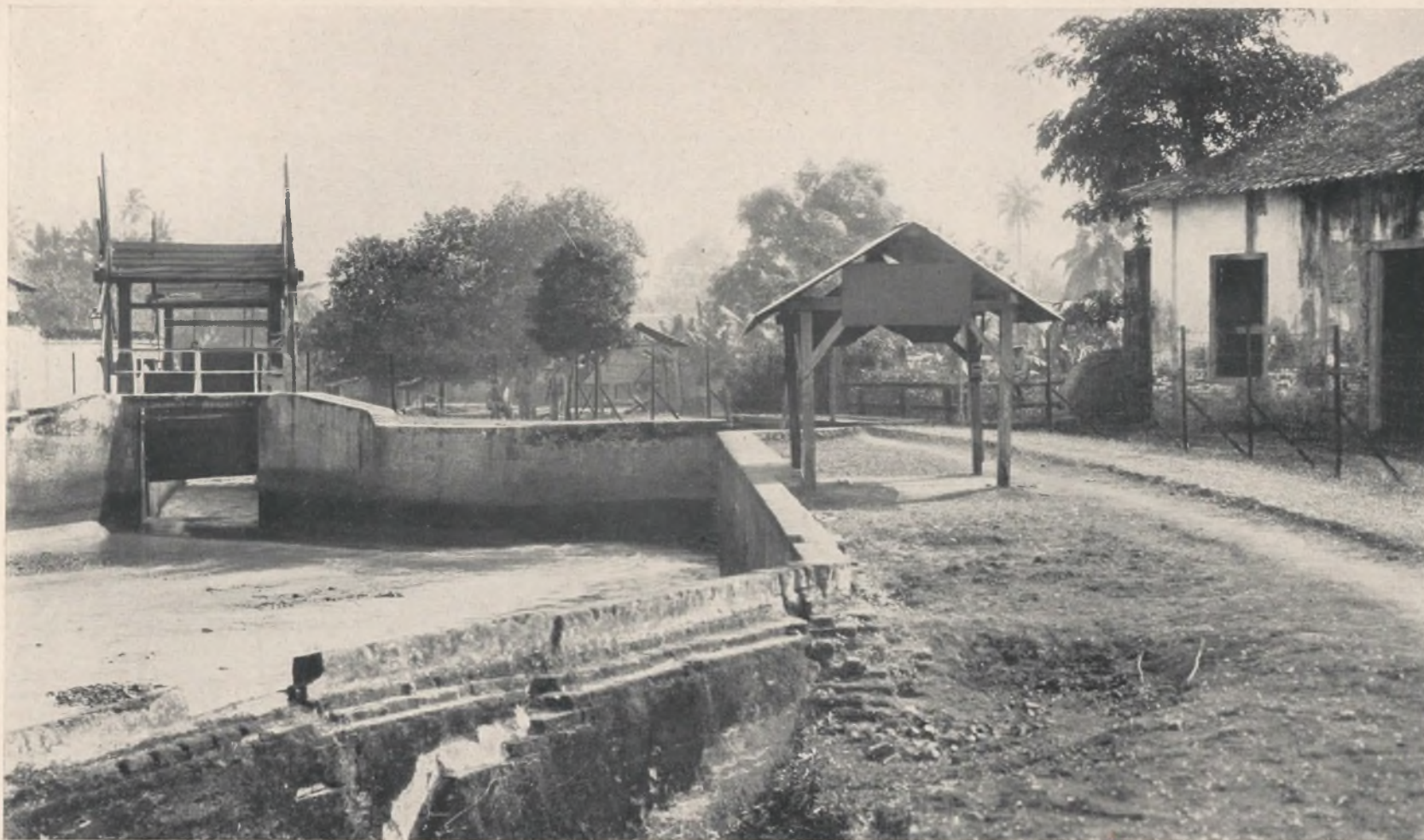
A 8. Gezicht van uit het Zuiden op de groote suatiesluis achter de gevangenis (716), genomen binnen het door prikkeldraad afgesloten gevangenissterrein. Het water komt van links uit den arm H H van onze photo A 7 (heden ten dage staat dit water stil, door de demping van den benedenloop van den Molenvliet). Naar rechts loopt dit water dood in de verstopte leiding (waarover twee bruggeljes, één binnen de omrastering en één daarbuiten) van den vroegeren molen (§ 718); men ziet de ruïne van het metselwerk, waarin eertijds het molenrad bevestigd is geweest, benevens het molenhuis. Op den achtergrond drie met Beaumontgeweren bewapende gevangenenbewakers; een vierde zit rechts op de brugleuning. De open wachthuisjes dienen om deze armzalige figuren tegen de zon te beschutten. Men bereikt dit terrein van uit Molenvliet eerst rechthoekig naar het Oosten, dan rechtsaan houdend en vervolgens links omhoog. De weg loopt tusschen het prikkeldraad en de molenruïne. Eertijds kon men hier ook komen van uit de Buitenkaaimansstraat, maar de bruggen over de kali en de Tangkivaar zijn thans weg.
