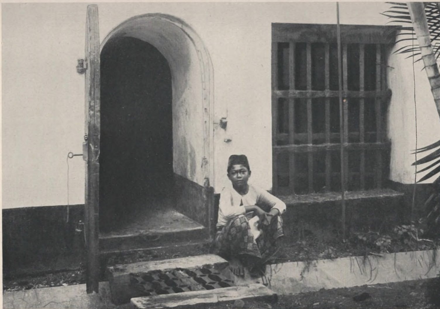
A 15. Een der vijf gevangenkelders aan den achterkant van het Stadhuis (§ 523), gezien van uit de binnenplaats, en wel de oostelijkste der drie van Schepenen. Goot met bruggelje, bestaande uit stukken dwarstralie. De inlandsche knaap is naast het deurtje gezet om de afmeting daarvan aan te geven. Het traliwerk bestaat uit eene dubbele rij (de achterste is nog even zichtbaar). De verticale slang is de bliksemafleider van het Stadhuis. De kelder heeft een tongewelf; de vloer loopt gelijk met den drempel. De diepte zal een pas of tien zijn. De geringe ventilatie door het venster werd vroeger nog belemmerd door een muurtje naar den kant der binnenplaats. Thans staan deze kelders leeg.
