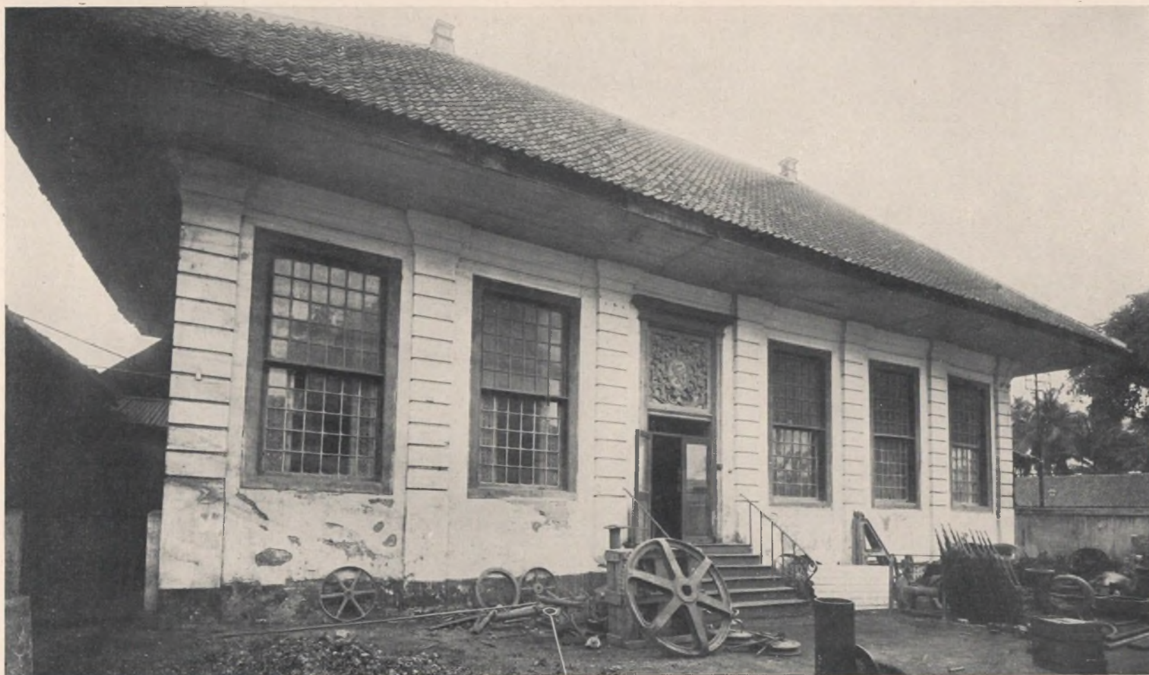
B 13. Gezicht van uit het Noorden op den muziekkoepel dwars op de oostzij van Molenvliet, vermeld in § 1137 en 1354, thans kantoor van Taylor en Lawson. Vierhoekig gebouw, bestaande uit eene enkele zaal. De stoep is modern. Gesculpteerd houten bovenlicht met pijlkoker, gekruist met een zwaard. Aan den achterkant eene dergelijke deur, waarvan het bovenlicht eene fluit en eene bazuin verloont. De uitsteeker loopt om het gansche gebouwte heen, evenals bij B 12. Achter de vensters ziet men de kunstig à jour bewerkte vouwbare binnenblinden, overeenkomend met die in de Compagnieskamer, photo B 24. Onder het huis is eene leiding uit den Molenvliet, die in het eigendomsbewijs van 1756 beschreven wordt als de „steen waschbak“. De koepel zelf wordt nergens uitdrukkelijk genoemd; de attributen boven de voordeur wijzen echter op een officier als bouwheer; vandaar onze onderstelling dat de koepel gebouwd is door G. F. Kircher, die in 1756 eigenaar van het perceel werd en van 1755 tot 1758 ritmeester der burgercavalerie was. De vensters zijn, blijkens de afmetingen, gelijk met de deur er in gezet, en dergelijke vensters dateren van ongeveer 1750. De achterzij heeft evenveel vensters als de voorgevel. Ook de groote afmeting van het bovenlicht wijst op denzelfden tijd (zie B 10).
